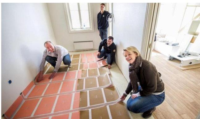
Foto 1: sensorlaminatet ligger i parallelle baner.
