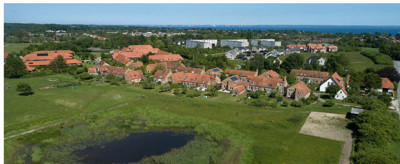
Bofællesskabet Bakken i Humlebæk indviede i 2019 et fælles jordvarmeanlæg, der forsyner de 27 boliger med grøn varme
