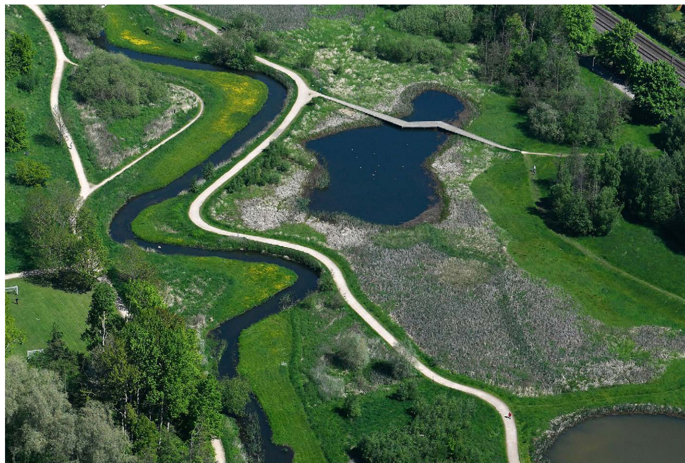
Der er etableret et dobbeltprofil langs Usserød Å for at sikre mod oversvømmelser
