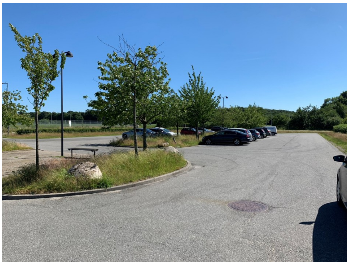
Dette er samkørselspladsen i Langeskov ved Mariendalsvej, tæt ved afkørslen fra motorvejen, anno 2022. Her er ikke nogen ladestanderne endnu. Men det kommer der frem mod 2025.
