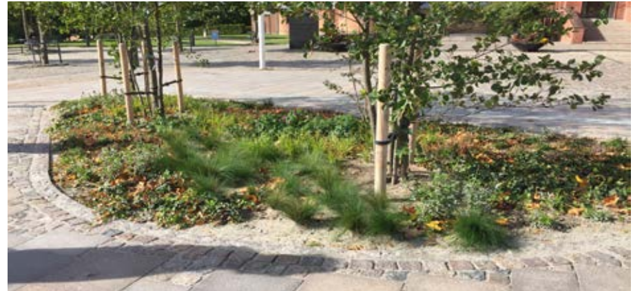
Eksempel på nedsivningsanlæg i Ringsted By.
